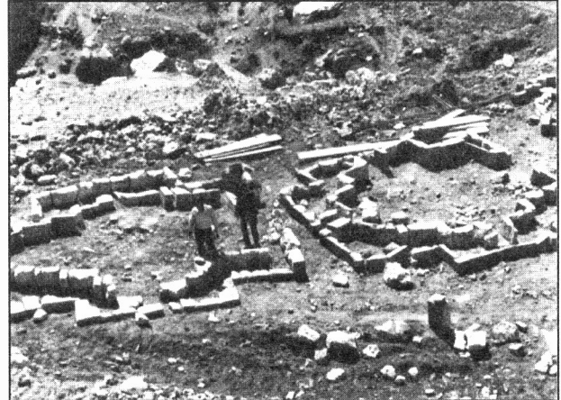
تصویر شماره ۲۷- ردیف چینی سنگهای پیاده شده ساختمان کلیسا مهرماه ۶۶، به منظور کنترل مجدد قبل از حمل سنگها به محل جدید به این صورت ردیف چینی و با نقشه تهیه شده مقایسه و کنترل می گردید
