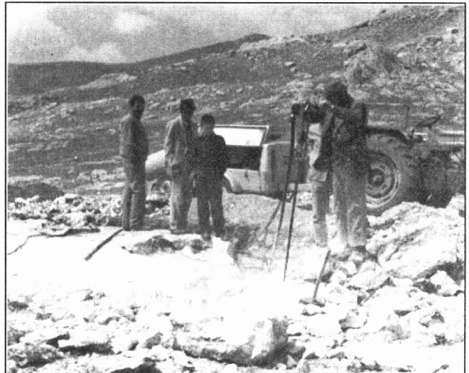
تصویر شماره ۴۳- شروع عملیات باز سازی کلیسا در محل جدید، با پی کنی محل مورد نظر دوباره سازی بنا آغاز می گردد.
