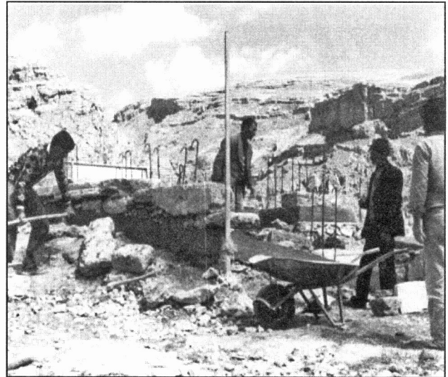
تصویر شماره ۴۹ - شروع عملیات پی سازی و کار گذاری اولین رج سنگهای ساختمان کلیسا به منظور ایجاد استحکام لازم ، نسبت به تعبیه شناژ بتن آرمه به صورت کم در داخل دیوارها طبق نقشه اقدام شد
