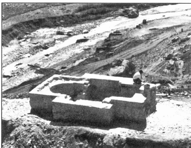
تصویر شماره ۲۲ - نمایی از کد گذاری بر روی لایه های سنگ چینی که بعد از کد نویسی بر روی سنگهای هر رج و تهیه نقشه های لازم اقدام به پیاده کردن آن شد .
