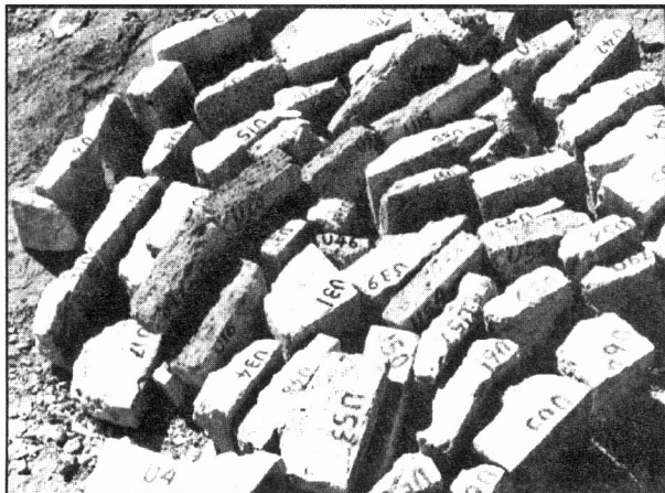
تصویر شماره ۳۰- نمایی از سنگهای پیاده شده که دارای کد و شماره گذاری می باشند
