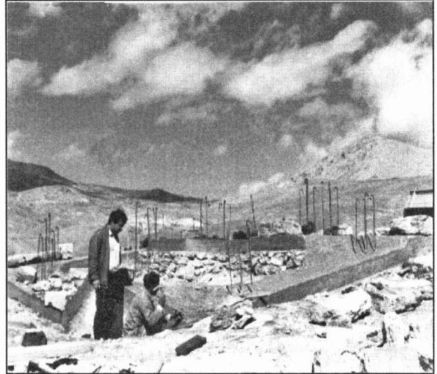
تصویر شماره ۴۷ - نمایی کامل از سکو سازی و ایجاد شیبهای مناسب برای کلیسا متناسب با فرم صخره ای جایگاه اولیه بنا و تعبیه شناژ تقویتی
