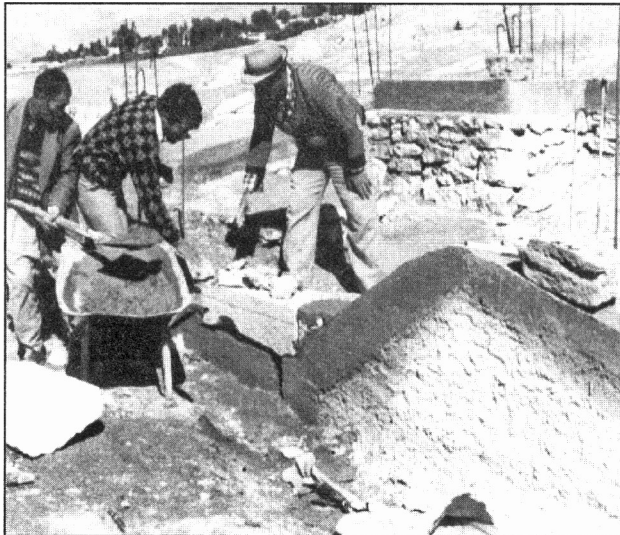
تصویر شماره ۵۰ - شروع عملیات ایجاد پی بتنی به منظور احداث سکو و شیب های هماهنگ با شالوده محل قبلی کلیسا و کار گذلری اولین سنگ دوباره سازی
