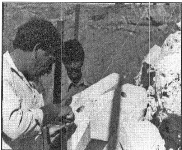
تصویر شماره ۶۸- معمار شیردل در حال کنترل بازسازی گنبد کلیسا بر اساس طرح مصوب
