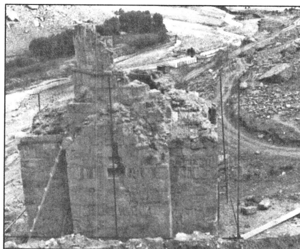
تصویر شماره ۸- نمای کامل از نمای شمالی کلیسا و موقعیت مکانی آن نسبت به رودخانه (قبل از جابجایی) آغاز عملیات اجرایی جهت مستند سازی و پیاده نمودن سنگهای دیوارهای کلیسا
