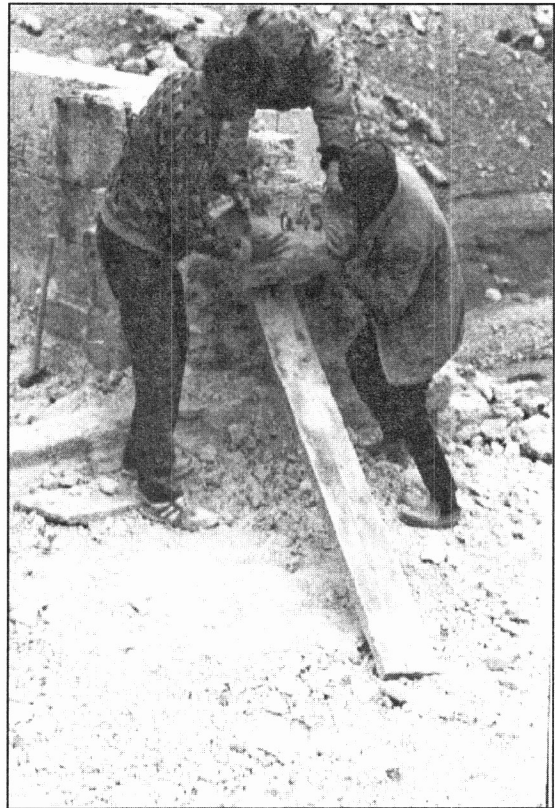
تصویر شماره ۲۳ - پس از کد گذاری، براساس نقشه تهیه شده سنگها با احتیاط از دیوار کلیسا پایین آورده می شوند.
